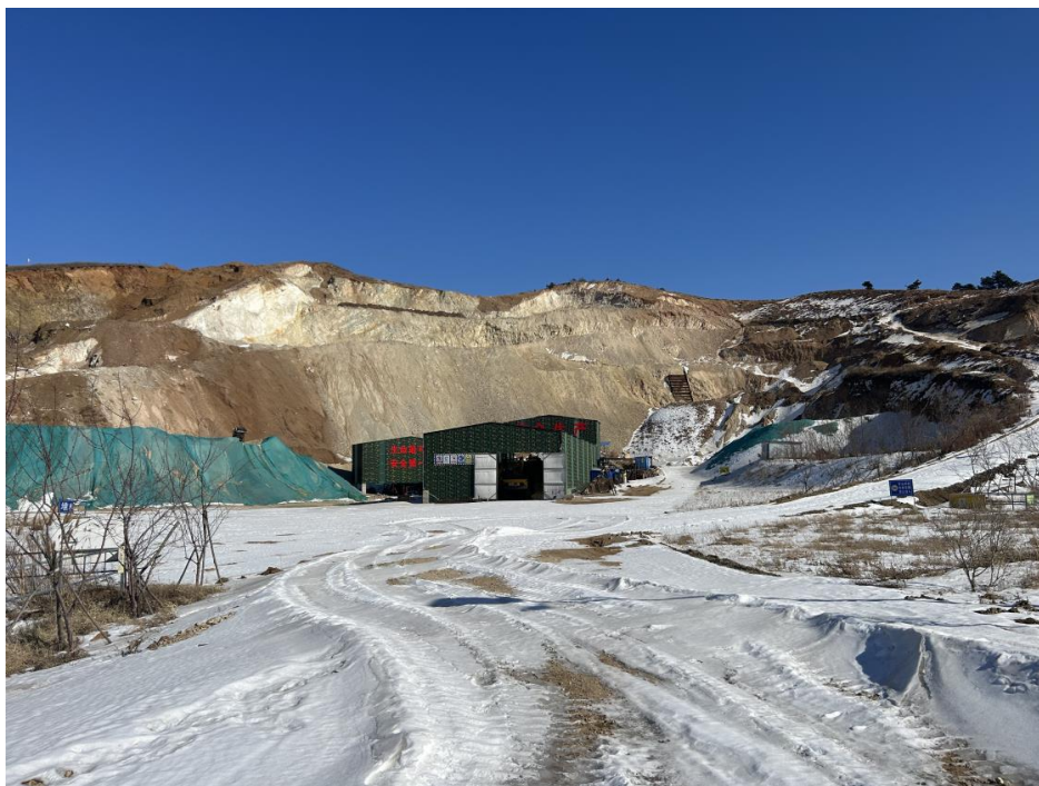
图 3-1 矿山部分边坡照片
